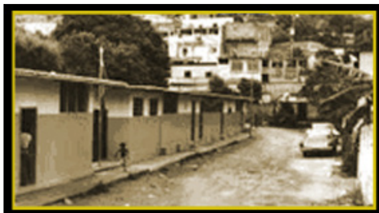
Fachada del Instituto San Pablo en su etapa inicial, cuando la calle principal era de tierra. Este Instituto fue fundado por los Martínez Centeno, una familia de destacados educadores venezolanos.
